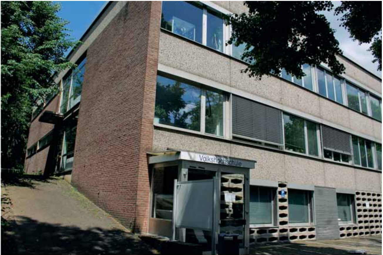
Das Bergheimer VHS-Haus soll umgebaut werden und einen Aufzug erhalten. Die Rampe links am Haus ist für Rollstuhlfahrer zu steil. BILD: VLAMINCK
