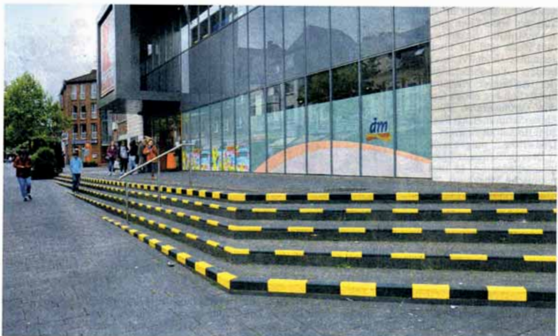
Gelb-schwarz gestreift sind die Kanten der Treppenstufen vor dem Kaufland-Gebäude zur Sicherung gegen Unfälle. (Foto: Fratz)
