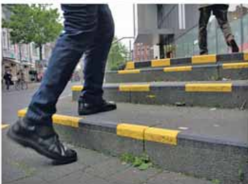
Sehr auffällig ist die neue und kontrastreiche Markierung auf den Stufen vor dem Kaufland-Supermarkt.
