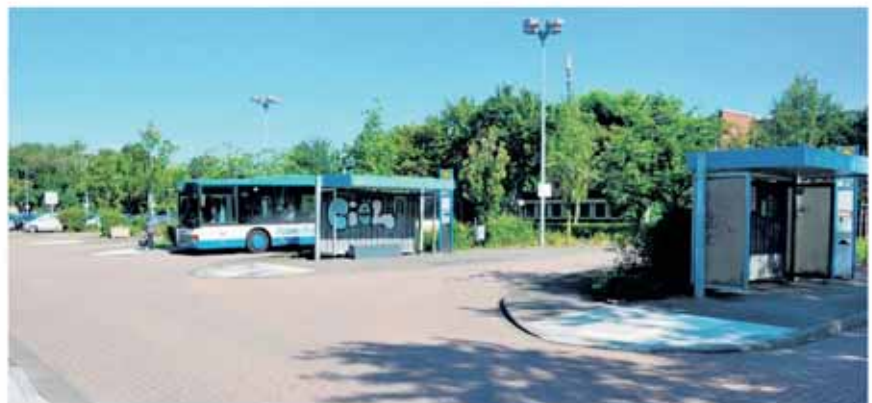
Der Zugang zu den Bussteigen am Rathaus wurde durch Bordsteinabsenkungen behindertengerecht umgebaut. (Foto: Fratz)
